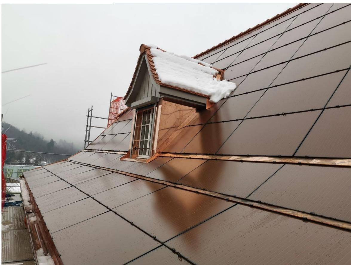
*Illustration 4: installation photovoltaïque intégrée au toit avec des panneaux de teinte spéciale (cure d'Ittigen, Sonnenrain 7)*
